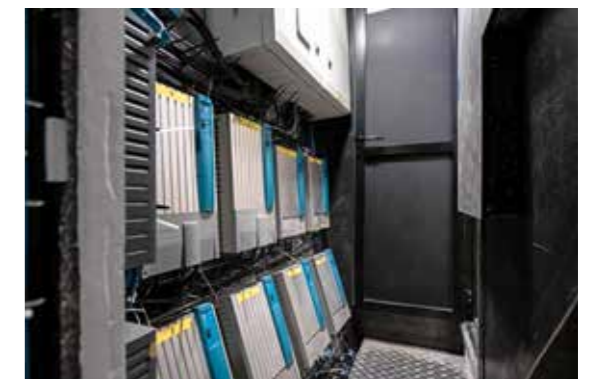
Le Leen 72 déploie huit chargeurs-convertisseurs Mastervolt spécialement conçus pour être associés à des batteries Lithium.
